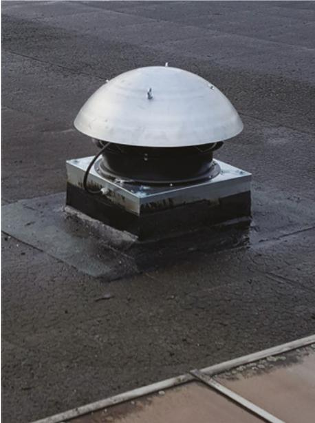
Présentes essentiellement sur le toit des bâtiments et usines, les tourelles de ventilation **ENGMAR** permettent l'insufflation ou l'évacuation d'air et de fumées. Il existe 2 types de tourelles ; les tourelles à jet horizontale TJH possédant un chapeau en tôle aluminium, ainsi que des tourelles à jet vertical TJV en acier galvanisé.
