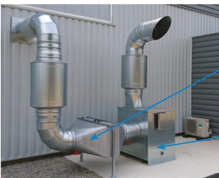
Fabriqués en tôle galvanisée, les **filtres** sont montés en glissière. En option, un indicateur d'encrassement permet de surveiller l'état des filtres qui sont accessibles par une trappe.
