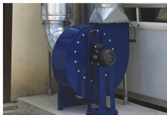
Les moto-ventilateurs employés sont de type centrifuge à pâles renversées permettant spécifiquement l'extraction de flux d'air chargés de poussières.
