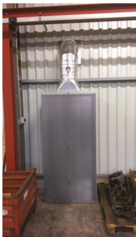
Les pléniums d'apport d'air extérieur permettent un apport d'air neuf mécanisé pour compenser un système d'extraction.
